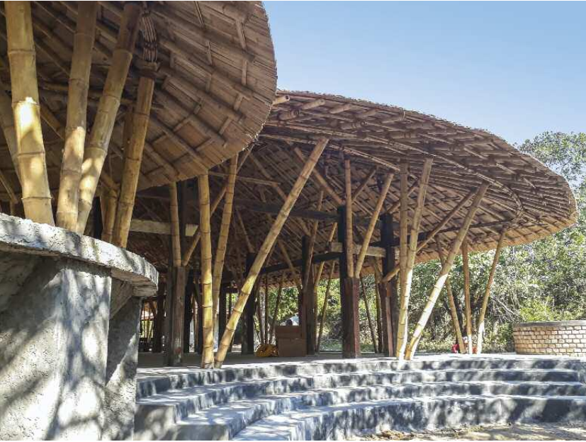
Myanmar: de diseño abierto y diáfano, el espacio multiusos de este centro tiene 25 metros de largo y unos 6 metros de alto. Está construido enteramente de bambú y cubierto con tejas de bambú.
