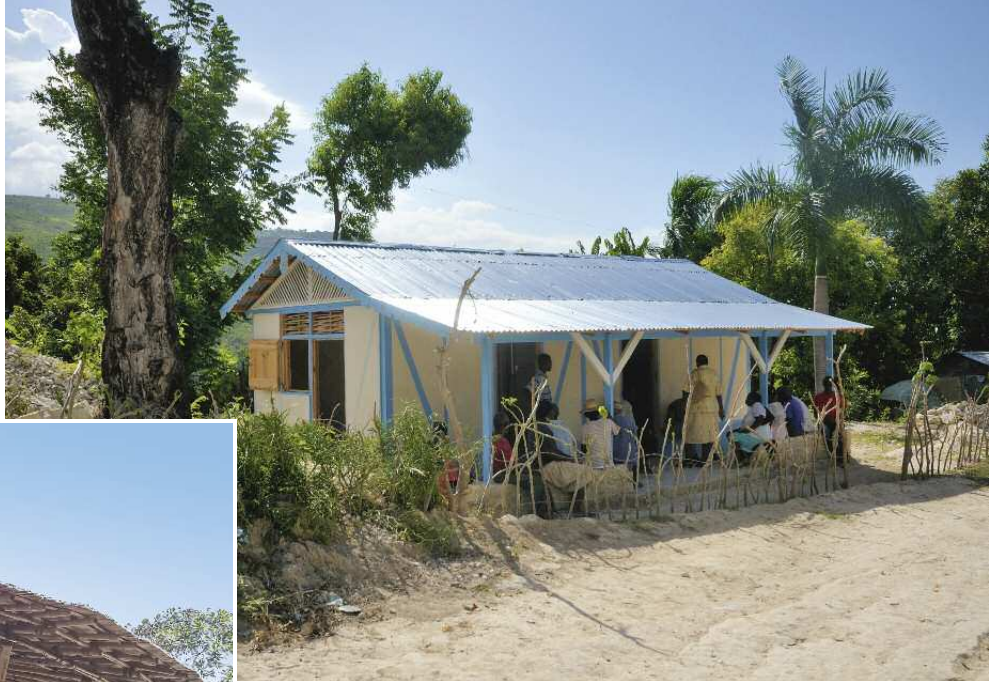
Haití: esta casa sismorresistente fue autoconstruida de forma tradicional con entramado de madera relleno de piedra natural.
