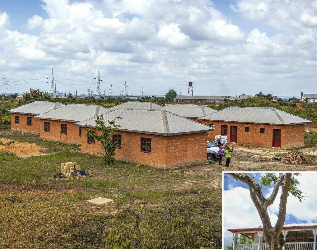
RD Congo: el centro de formación está construido con tierra (bloques de tierra comprimida). El material se obtuvo directamente in situ.
